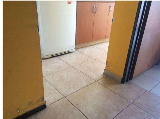
Figs. 1 y 2. Cecilia ingresando a su cocina, el apoyabrazos de su scooter engancha la arista de la pared y la rompe continuamente. El ancho de paso es de 70cm por 90cm y se observan ambas aristas erosionadas porque no es suficiente para el radio de giro que necesita.
