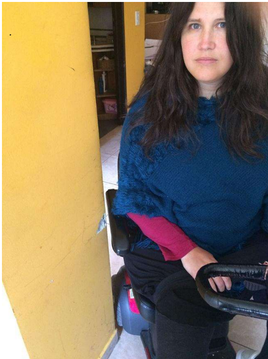
Figs. 1 y 2. Cecilia ingresando a su cocina, el apoyabrazos de su scooter engancha la arista de la pared y la rompe continuamente. El ancho de paso es de 70cm por 90cm y se observan ambas aristas erosionadas porque no es suficiente para el radio de giro que necesita.
