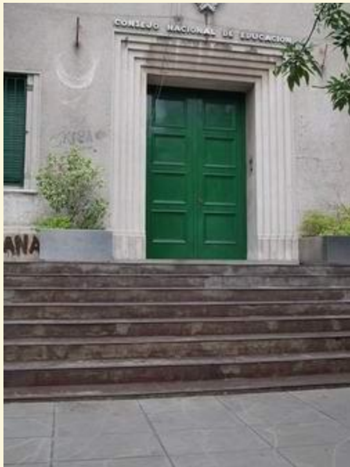
1 Escuela sin rampa
