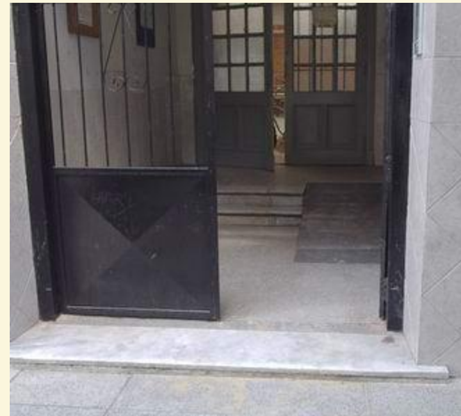
2 Escuela con rampa de pendiente pronunciada 8
